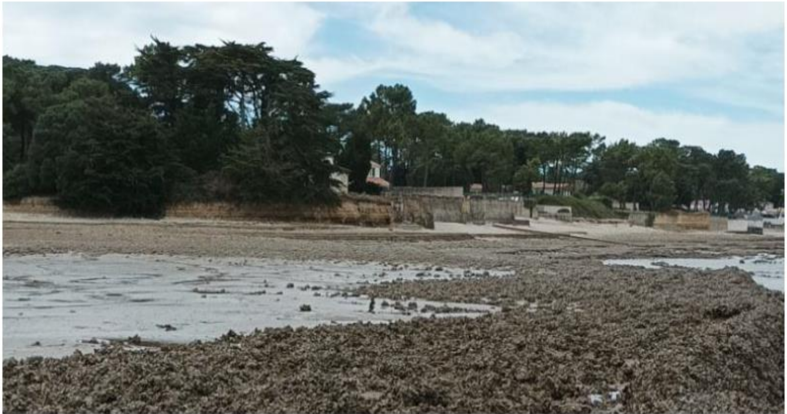
Vue côté Nord de l'écluse.
