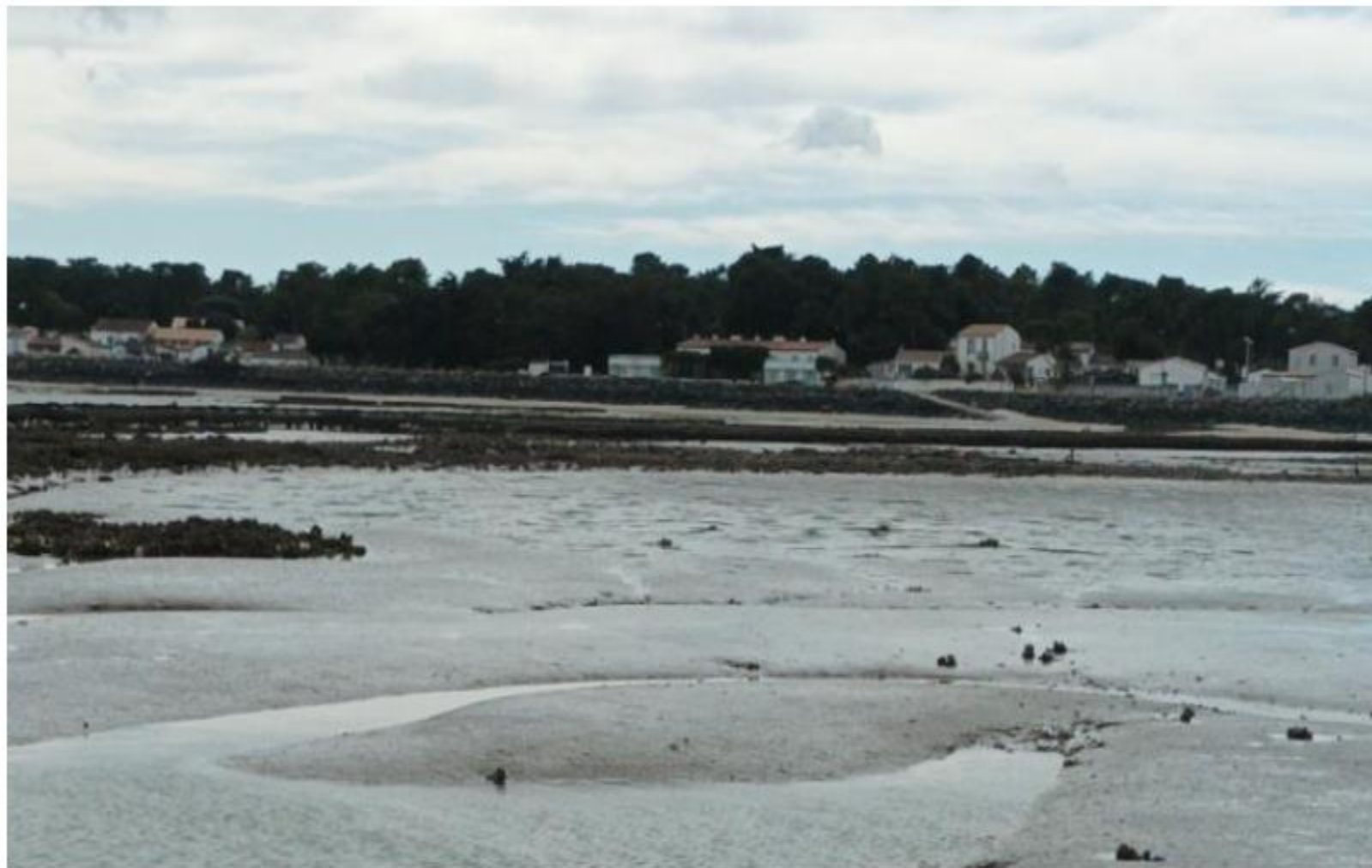
Vue côté Ouest de l'écluse.
