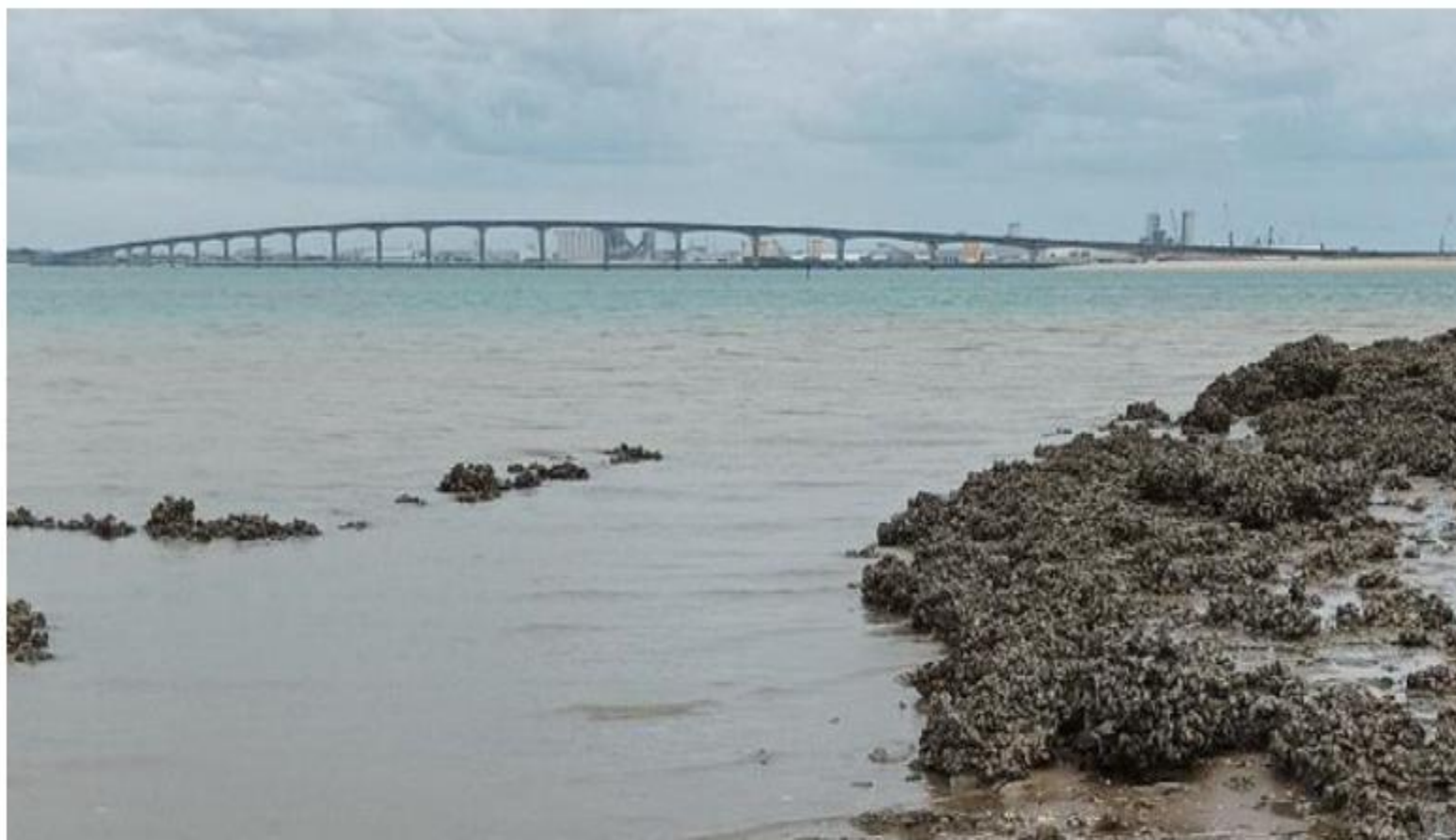
Vue côté sud de l'écluse.
